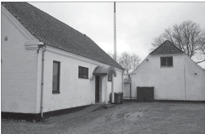
Her ses Brændskov Forsamlingshus, og til højre i billedet ses bygningen med de to lejemål, der nu ønskes nedrevet.
