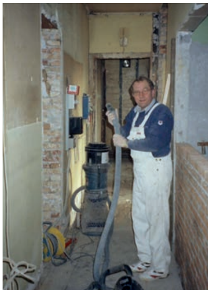
Murermesteren på arbejde.
