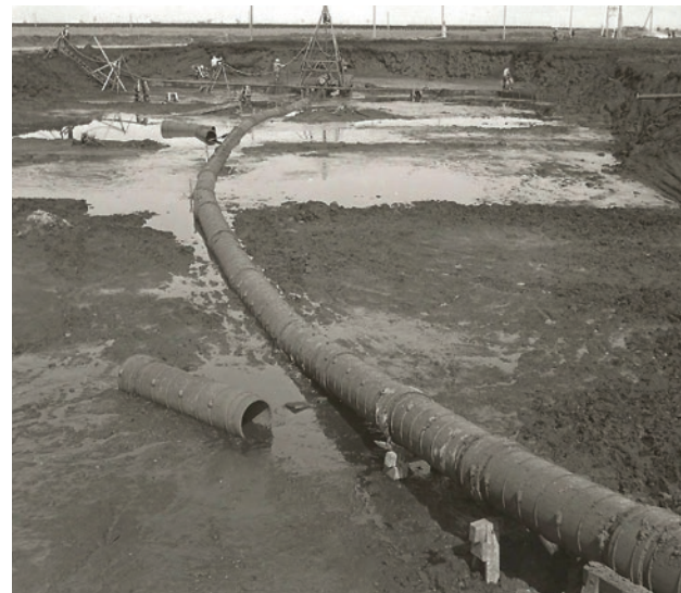
2. Derefter pumpes trøvemudret ca 1 km op til den sande mark i den her rørledning.
