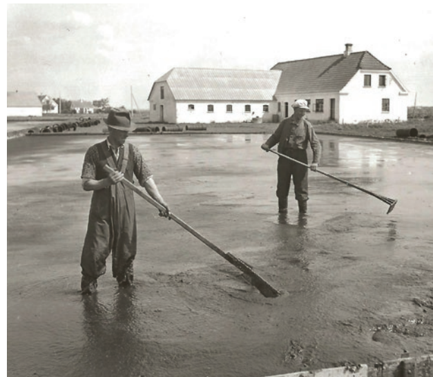
3. På marken bliver mudret jævnet ud så den er på tykkelse med en mursten og lagt til tørre.
