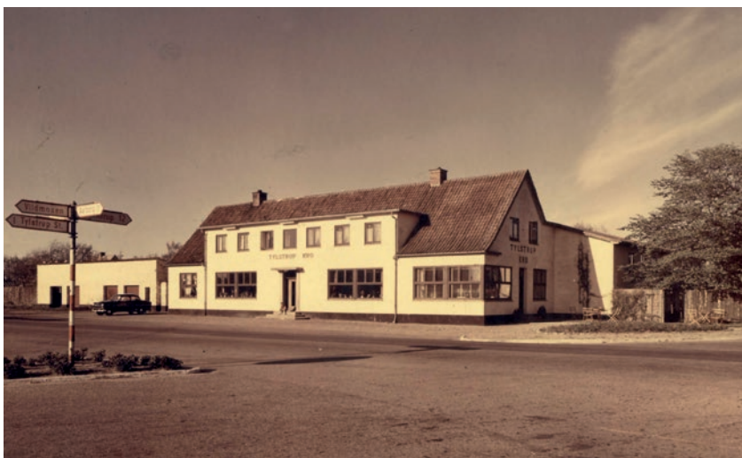
Tylstrup Kro fra før branden. Jørn boede bag første vindue til højre på 1. sal.
